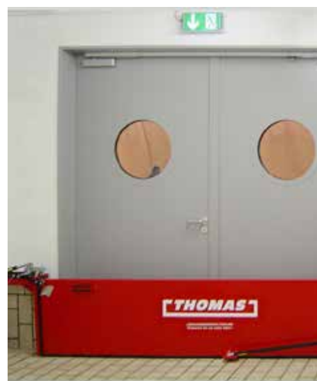
Barrière automatique pivotable verticalement, remise en place manuelle
