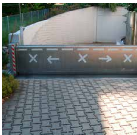
Cloison étanche rabattable pour garage souterrain, immeuble locatif Mühleliweg, Tuggen
