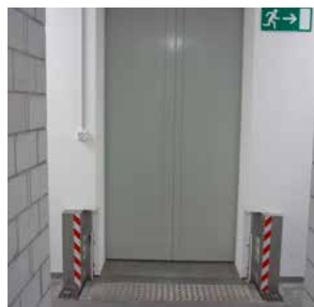
Entrepôt de produits dangereux, Landi Reba, Aesch
