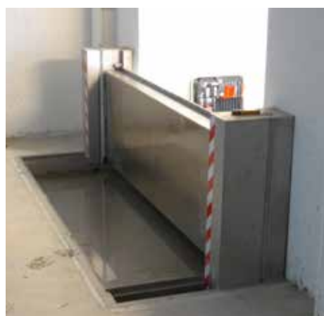
Entrepôt de produits dangereux, Villars Maître Chocolatier
