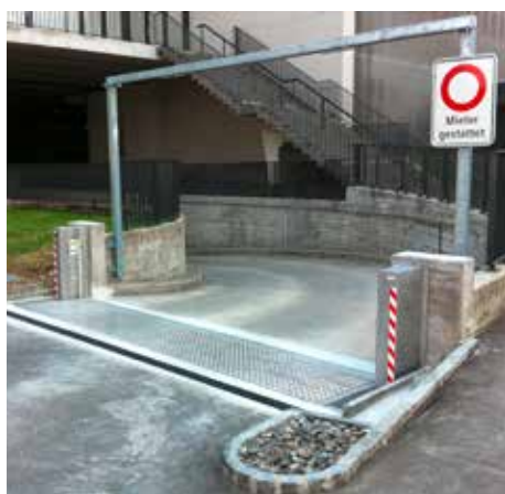
Cloison étanche rabattable pour garages souterrains, centre commercial, Spreitenbach
