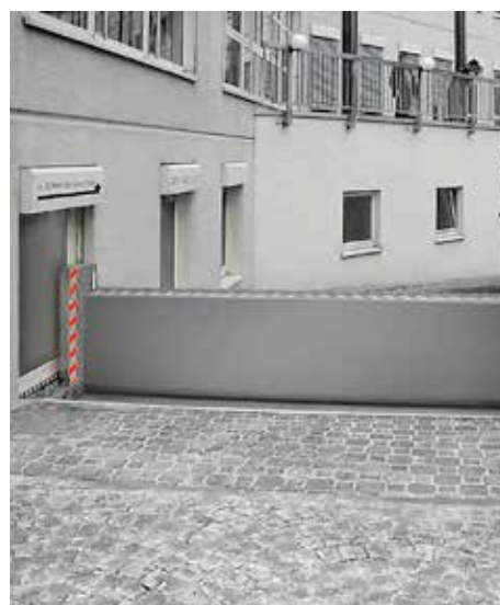
Barrière de rétention pour rampes d'accès de garages souterrains
