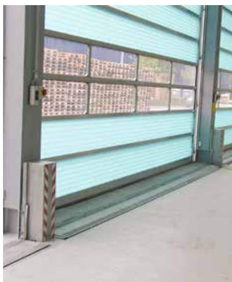
Barrière de rétention pour rampe de chargement
