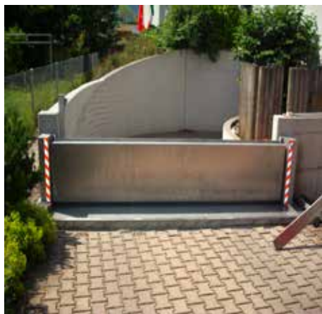
Barrière de rétention pour garage souterrain, immeuble locatif Mühleliweg, Tuggen
