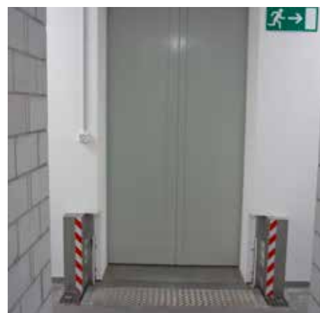
Entrepôt de produits dangereux, Landi Reba, Aesch
