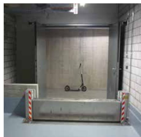
Entrepôt de produits dangereux du centre de tri postal de Mülligen, Schlieren
