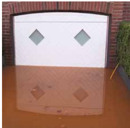
Une fois fermée, la porte est totalement étanche, sans aucune autre manipulation
